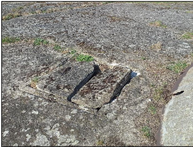
Pour accéder sous la calotte de 170 mod. 38 K, un passage est aménagé par cette entrée en puits fermée par des dalles de béton.
