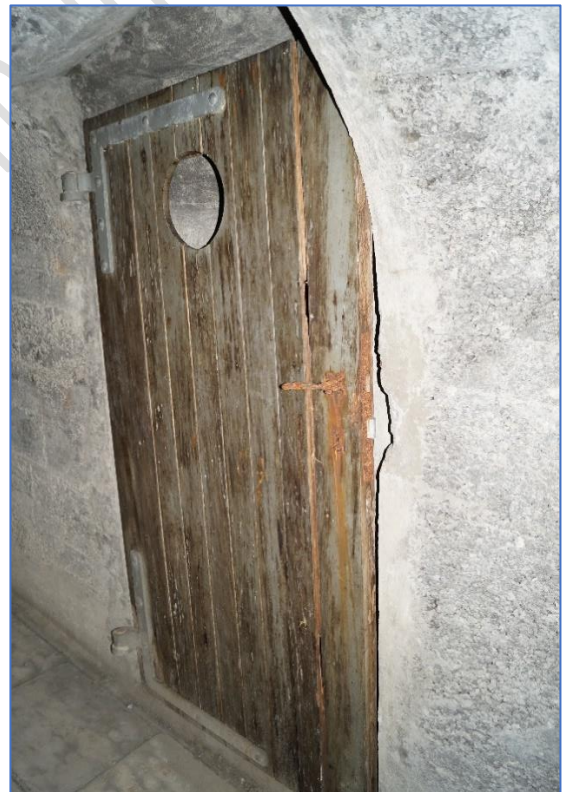
Dans la galerie menant au bloc Canal Nord (Eben-Emael), il y a l'accès factice au bloc K et à sa coupole de 220 mod. 38 K située près de Mi Nord.
