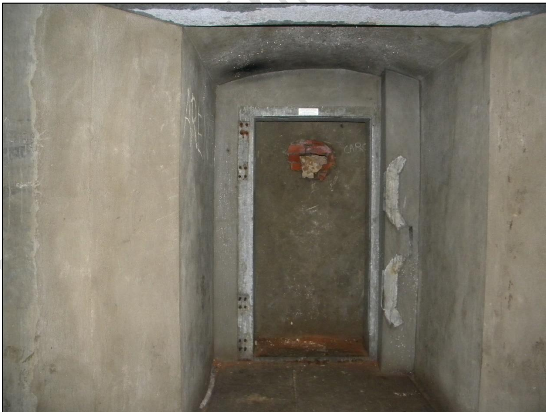
Le Bloc K pour une cloche de C.47 mod. K du fort d'Aubin-Neufchâteau avant sa disparition. Remarquons son remarquable champ de tir. Son accès factice comporte un tronçon de galerie fermé par une porte P.H.C.
