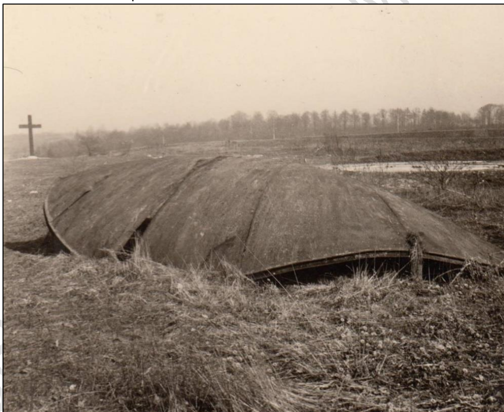
Une des deux coupoles pour un mortier de 220 mod. 38 K d'Eben-Emael détruite lors de l'assaut allemand du 10 mai 1940.
