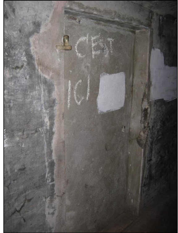
L'accès factice à la coupole de 170 mod. 38 K n'a plus sa porte en bois.
