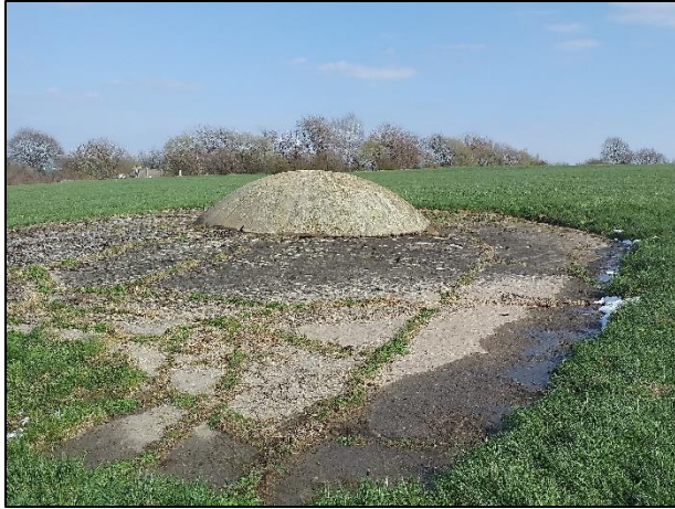
Le bloc K de la coupole de 170 mod. 38 K présente sensiblement la même forme que celui d'une coupole de 2 x 120 mm mod. 1931.
