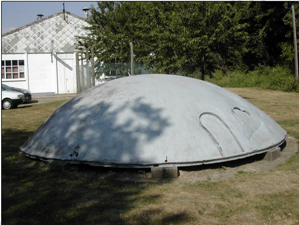
La seule fausse coupole de 120 mm survivante des combats de mai 1940 à Eben-Emael a été déplacée à l'entrée du fort.
