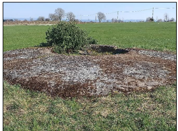
Massif bétonné de la cloche C.47 mod. K du fort de Battice
