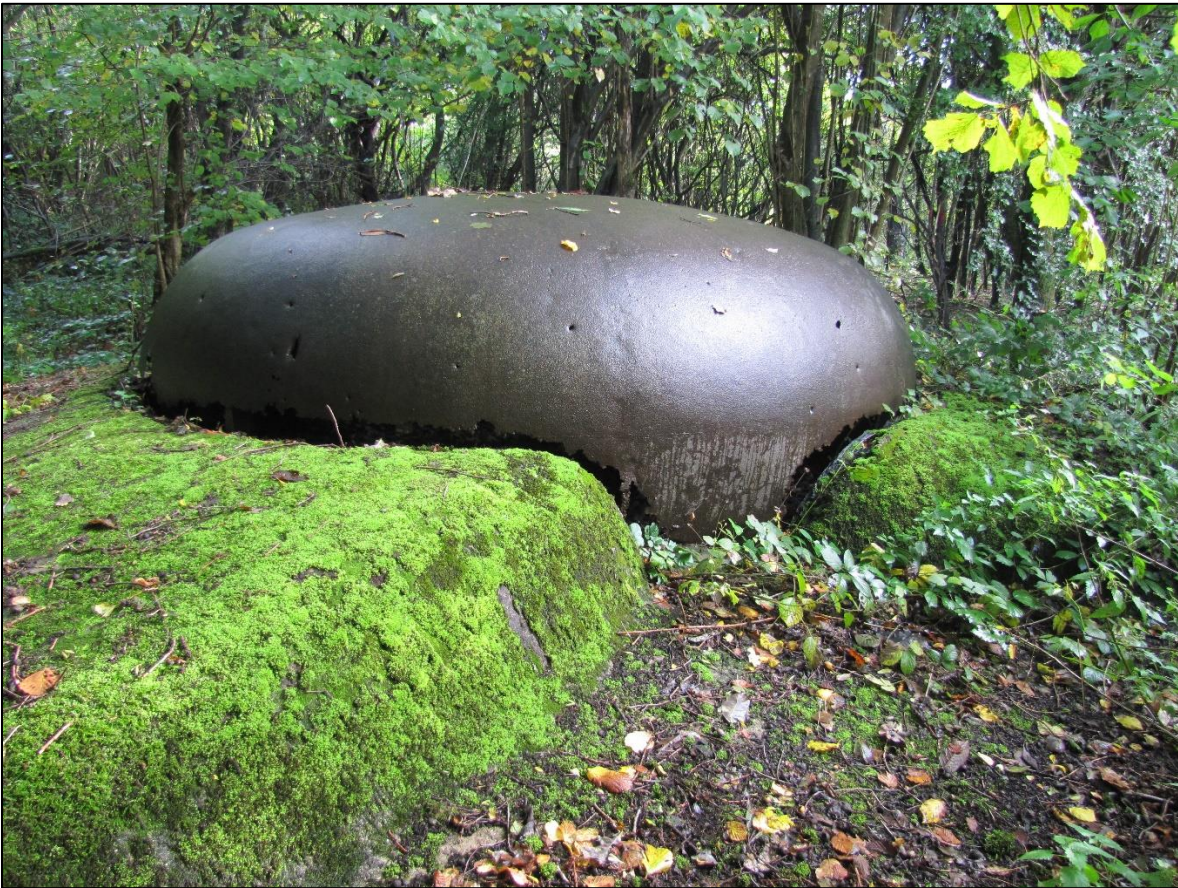
La seule cloche de C.47 mod. K subsistante est celle du fort de Tancrémont.
