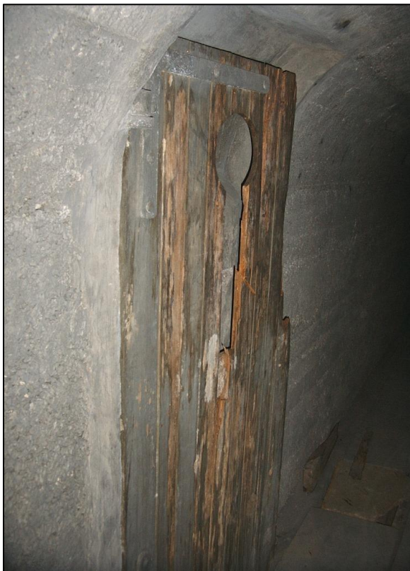
Dans la galerie menant au bloc O1 (Eben-Emael), il y a l'accès factice au bloc K et à sa coupole de 170 mod. 38 K
