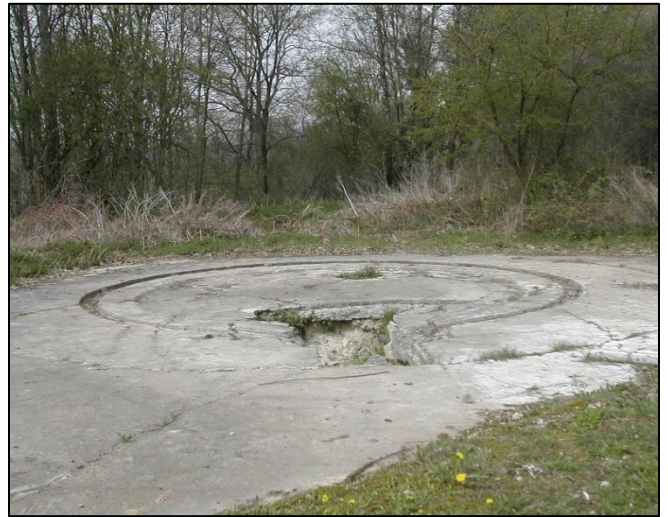
Bloc K pour la coupole de 1 mortier de 220 mod. 38 K située près de Mi Nord (Eben-Emael).
