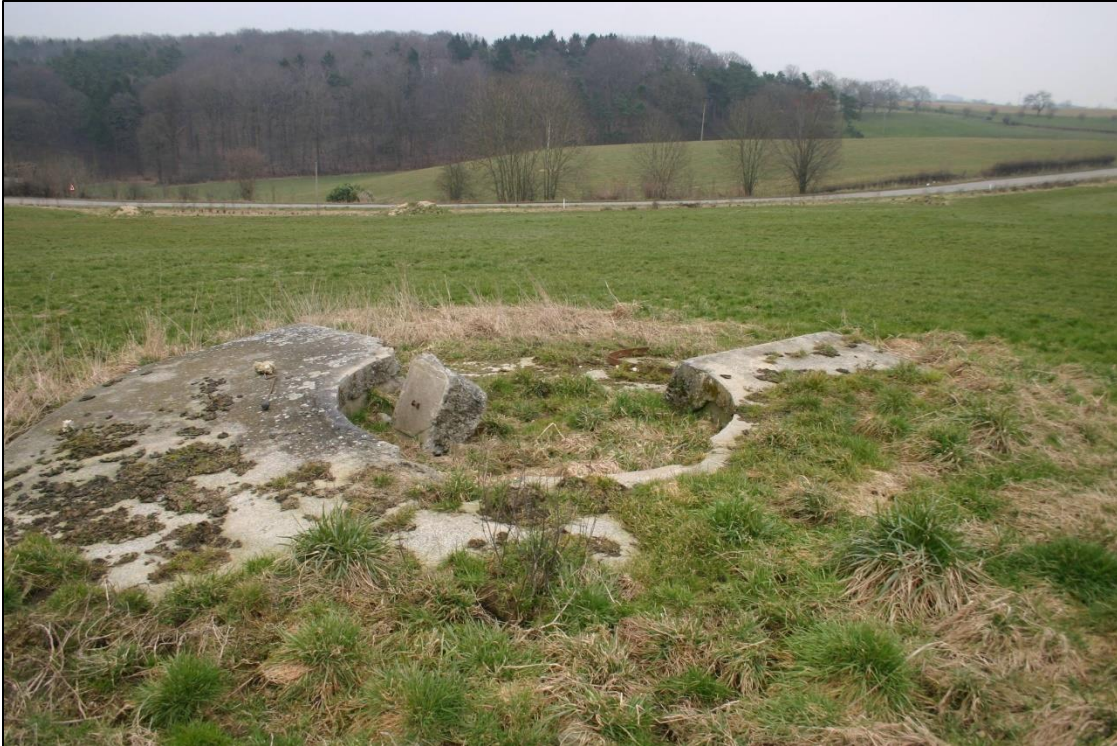
Le Bloc K pour une cloche de C.47 mod. K du fort d'Aubin-Neufchâteau avant sa disparition. Remarquons son remarquable champ de tir. Son accès factice comporte un tronçon de galerie fermé par une porte P.H.C.
